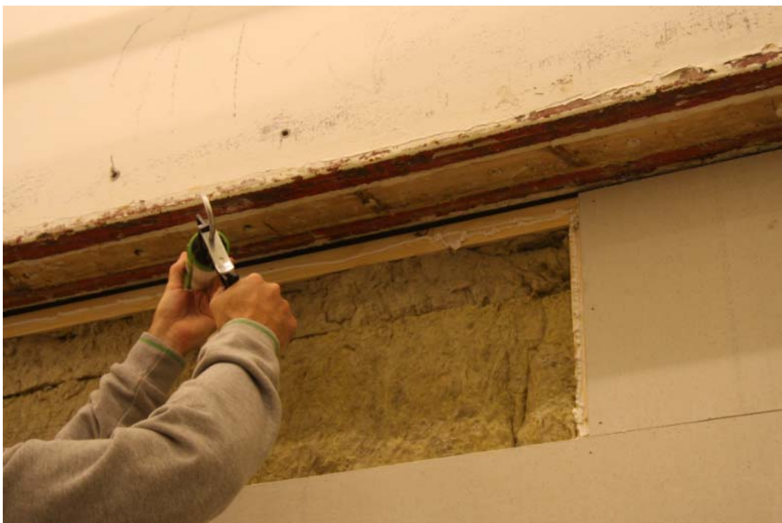
Bild 8 – Utrymmet mellan reglarna fylldes helt med stenull.
