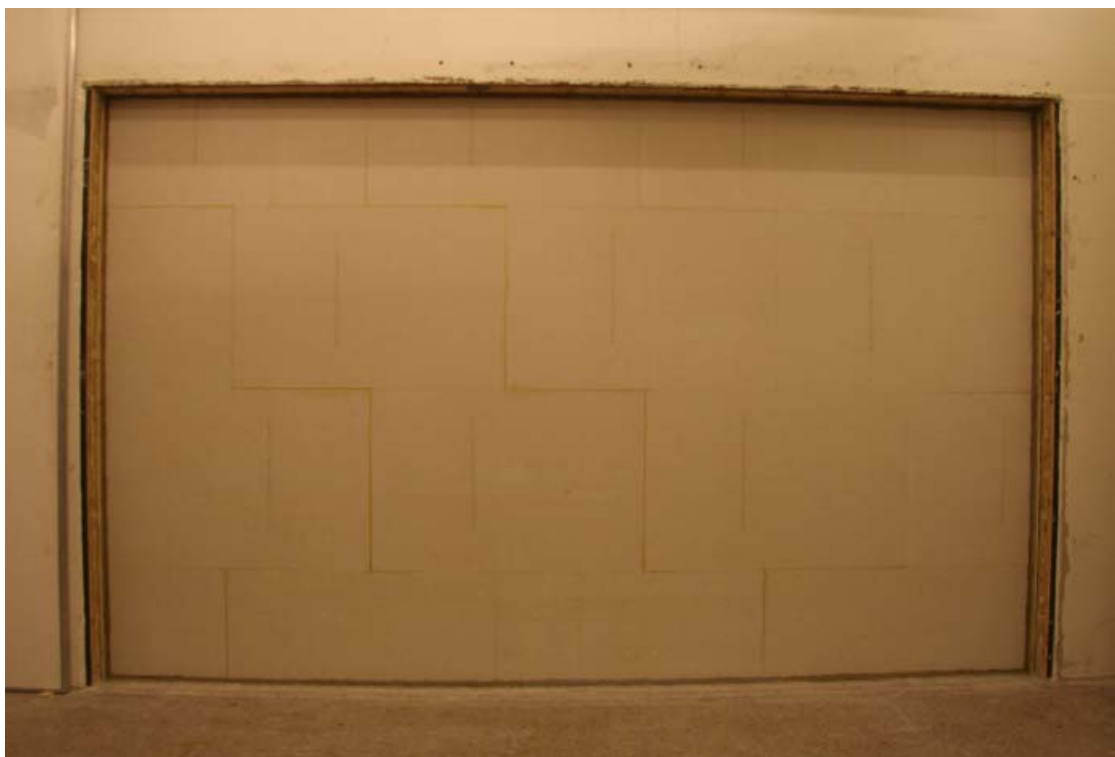
Bild 15 – Vägg i bilaga 4 sedd från mottagarrumssidan, 1 lag gips.
