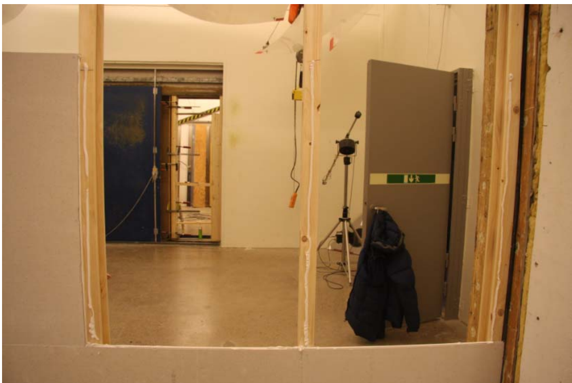
Bild 5 – Gipsskivorna fästes mot reglar och skenor med lim och dyckert. Samtliga skivskarvar limmades.
