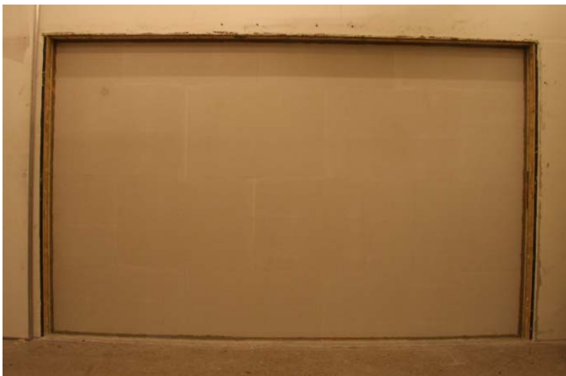
Bild 10 – Vägg i bilaga 1 och 2 sedd från mottagarrumssidan, 1 lag gips.
