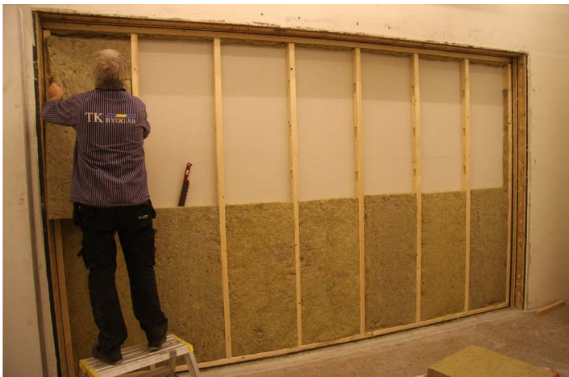
Bild 14 – Under montering av vägg i bilaga 4.
