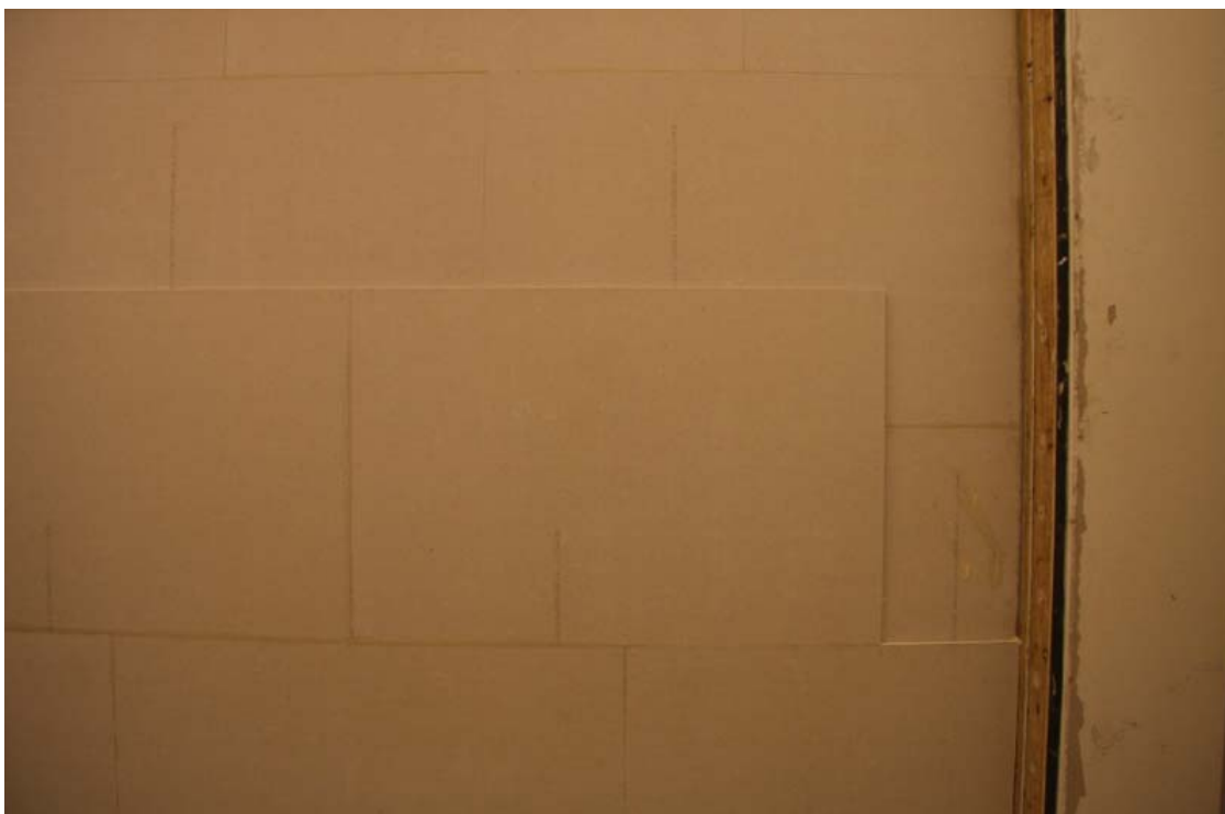
Bild 17 – Montering av andra gipslaget på mottagarrumssidan (vägg i bilaga 5).
