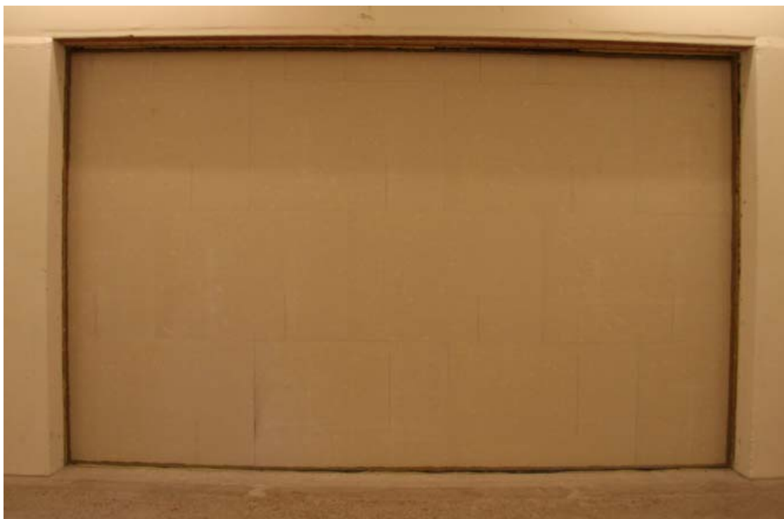
Bild 16 – Vägg i bilaga 4 sedd från sändarrumssidan, 1 lag gips. Denna sida är oförändrad i bilaga 5.
