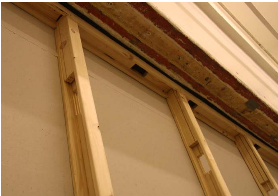
Bild 7 – Samtliga reglar fästes med en speciell kil upptill, se bild.
