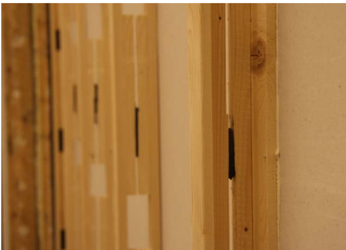
Bild 6 – EPDM-list monterades i spåret mitt på varje Smart.AX ljud-regel.
